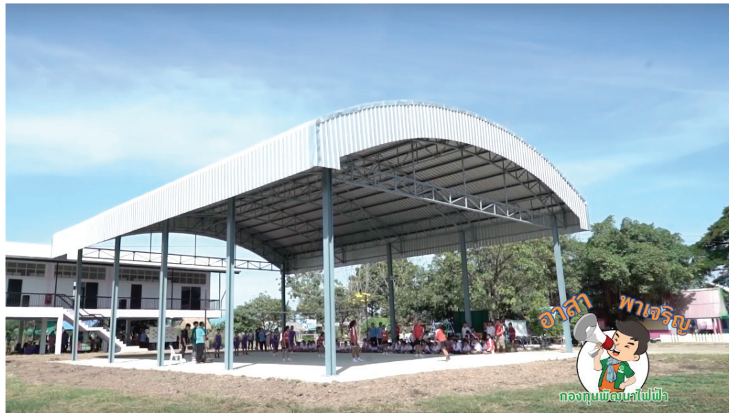
โครงการก่อสร้างอาคารอเนกประสงค์ ร.ร.บ้านมะม่วงเจ็ดต้น กองทุนพัฒนาไฟฟ้าจังหวัดลพบุรี 1 จ.ลพบุรี
