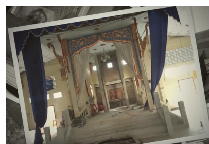
เมรุฌาปนสถานแบบเก่าใช้เชื้อเพลิงจากฟืนไม้ ทำให้เกิดมลพิษไปทั่วพื้นที่
